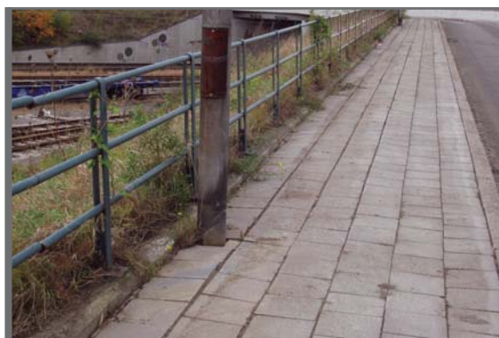
Figure 3.6 Les affaissements sont un milieu idéal pour l'apparition des mauvaises herbes
