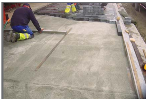
Figure 3.23 Mise en œuvre de la couche de pose
