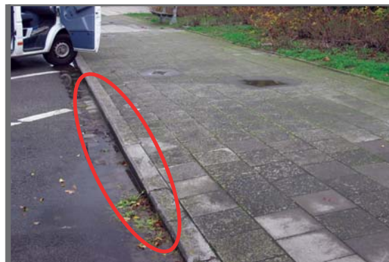
Figure 3.13 En raison de l'eau, de la terre et des matières organiques qui peuvent s'y accumuler, les filets d'eau adjacents en éléments modulaires constituent un milieu idéal pour les mauvaises herbes
