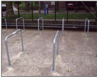
Figure 3.8 Éviter un revêtement semi-ouvert sous le mobilier urbain et/ou choisir le mobilier en fonction de l'entretien futur (obstacles amovibles, mobilier déplaçable)
