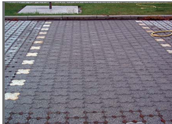
Figure 3.45 Matériau de jointoiment perméable lié aux polymères utilisé avec des pavés à ouvertures de drainage pour contrecarrer l'apparition des mauvaises herbes (2008)
