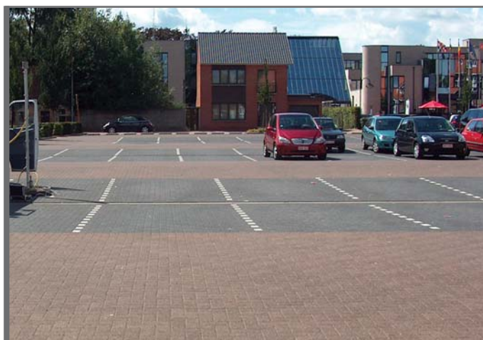
Figure 1.3 Parking en pavage drainant
