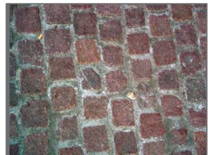
Figure 3.35 Exemple de revêtement rejointoyé avec du mortier modifié
