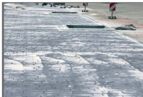
Figure 3.27 Matériau de jointoiment classique non lié
