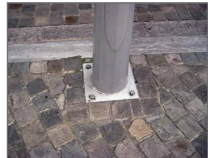
Figure 3.8 Éviter un revêtement semi-ouvert sous le mobilier urbain et/ou choisir le mobilier en fonction de l'entretien futur (obstacles amovibles, mobilier déplaçable)
