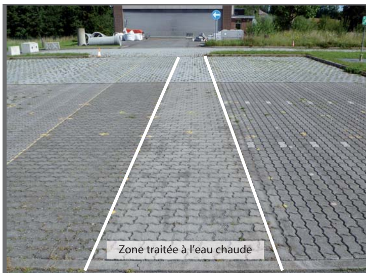
Figure 4.22 Impact des traitements à l'eau chaude sur la clarté des pavés. Comparaison visuelle avec photo, prise le 4 août 2011.
