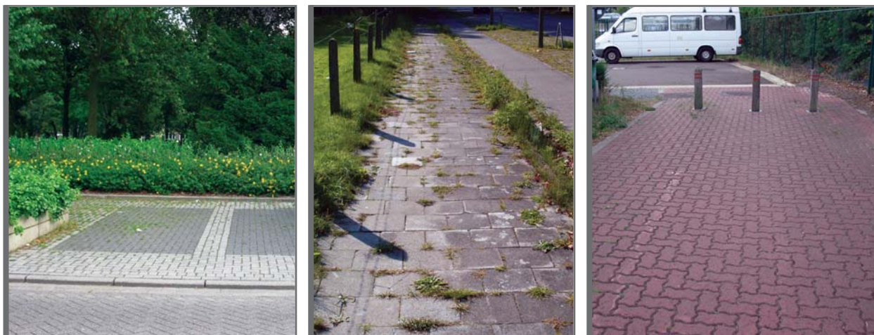
Figure 2.1 Les facteurs circonstanciels (zones vertes adjacentes, piétinement, fonction) déterminent le risque d'apparition des mauvaises herbes ainsi que le degré de tolérance
