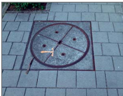
Figure 3.9 Une bonne finition du revêtement routier autour des obstacles combat l'apparition des mauvaises herbes
