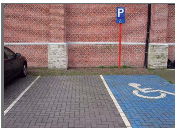
Figure 3.19 Exemple de prise en compte insuffisante de la future gestion (alternative) des mauvaises herbes: zone problématique entre les emplacements de parking et le mur, zone peu utilisée (circulée) et qui, en raison des nombreux obstacles (parking à vélos, armoires électriques, poteaux), sont difficiles à entretenir mécaniquement
