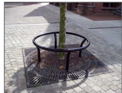
Figure 3.9 Une bonne finition du revêtement routier autour des obstacles combat l'apparition des mauvaises herbes
