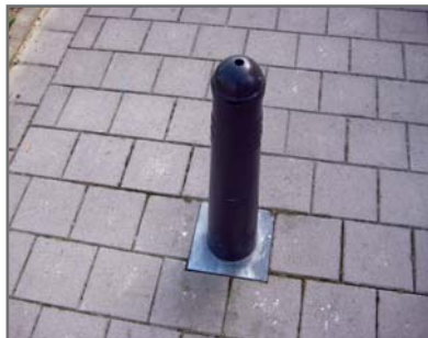
Figure 3.8 Éviter un revêtement semi-ouvert sous le mobilier urbain et/ou choisir le mobilier en fonction de l'entretien futur (obstacles amovibles, mobilier déplaçable)
