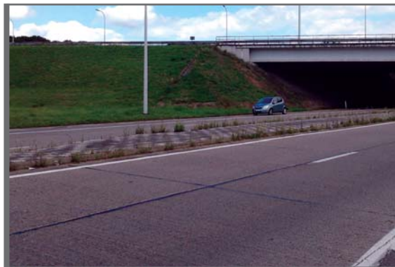
Figure 3.10 Sur certains aménagements routiers avec un revêtement modulaire ou un design spécial pour lesquels on n'a pas utilisé de matériau de jointoiment approprié, la maîtrise des mauvaises herbes pose souvent problème.
