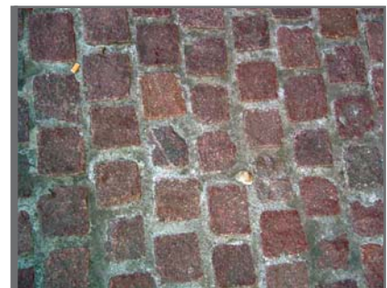
Figuur 3.35 Voorbeeld van met gemodificeerde mortel gevoegde verharding
