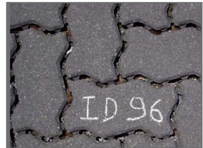
Figuur 3.40 Betonstraatstenen met verbrede voegen
