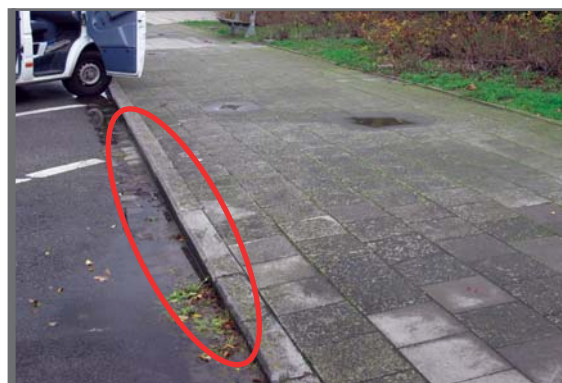
Figuur 3.13 Door de opeenhoping van water, grond en organische materialen vormen aanliggende straatgoten van kleinschalige elementen vaak een voedingsbodem voor onkruidgroei
