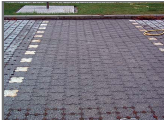
Figuur 3.45 Polymeergebonden, onkruidwerende én doorlatende voegvulling in stenen met drainageopeningen (2008)
