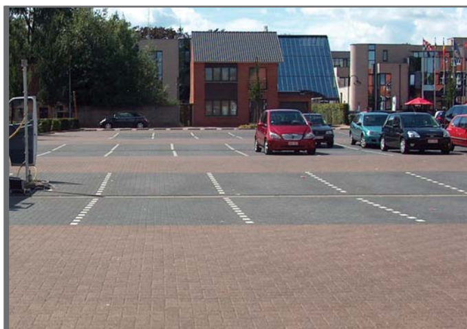
Figuur 1.3 Waterdoorlatende bestrating op een parkeerterrein
