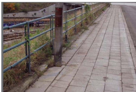
Figuur 3.6 Verzakkingen zijn een ideale voedingsbodem voor onkruidgroei
