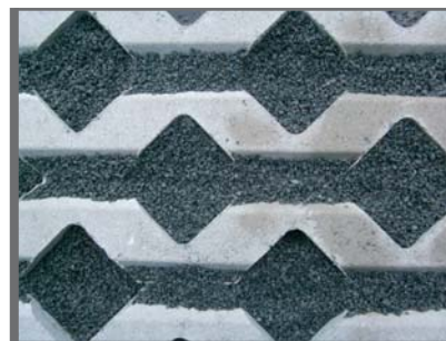
Figuur 3.43 Grasbetontegels met steenslagvulling
