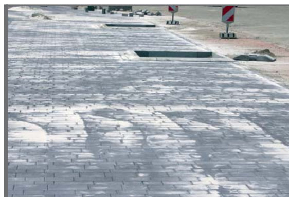
Figuur 3.27 Klassieke voegvulling van ongebonden materiaal
