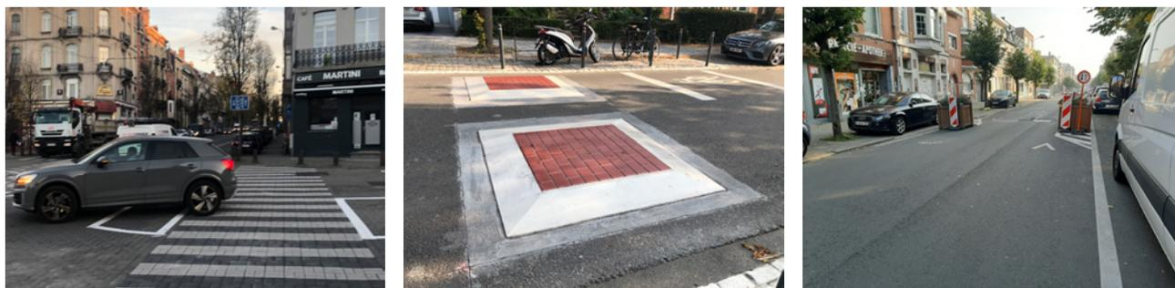
**Figure 1** – Observations faites lors des visites: à gauche: un conducteur qui ne respecte pas les rétrécissements par marquage; au centre: coussins berlinois accompagnés des arceaux à vélos pour interdire le stationnement; à droite: un rétrécissement par obstacle placé sur une piste cyclable suggérée (source: CRR)
