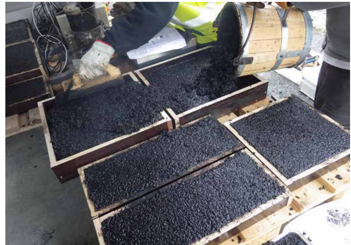
Figure 8.1 – Remplissage d'un moule en bois sur chantier avec de l'asphalte coulé chaud
