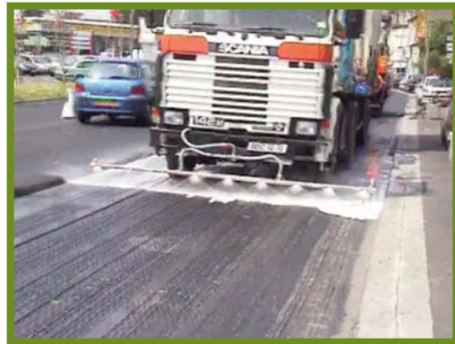
Figuur 6 Aanbrenging van kalkmelk om de kleeflaag tegen uitrukken door bouwverkeer te beschermen
