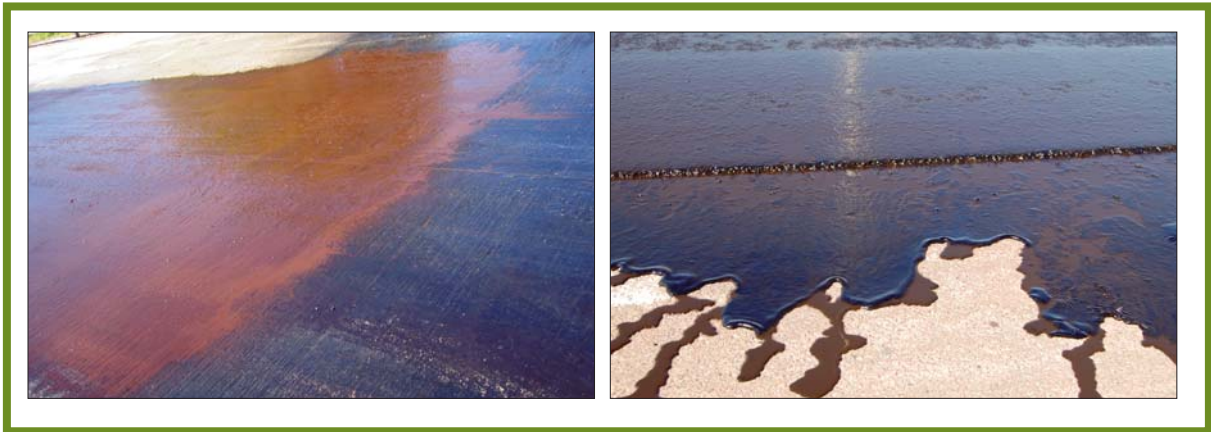
Figuur 4a Strook met een niet-gebroken emulsie (bruine kleur) en een gebroken emulsie (zwarte kleur),
