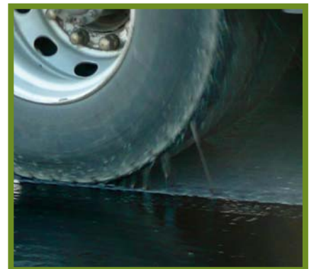
Figuur 5 Pas gesproeide laag kleeft aan de banden van bouwmachines
