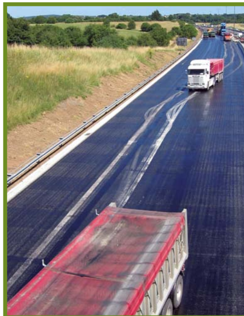
Figure 7 Exemple d'arrachement de la couche de collage par les roues des véhicules de chantier
