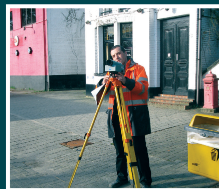
Topografische meting van het profiel van de verharding ter controle
