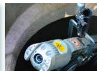
Rioolinspectie met camera
