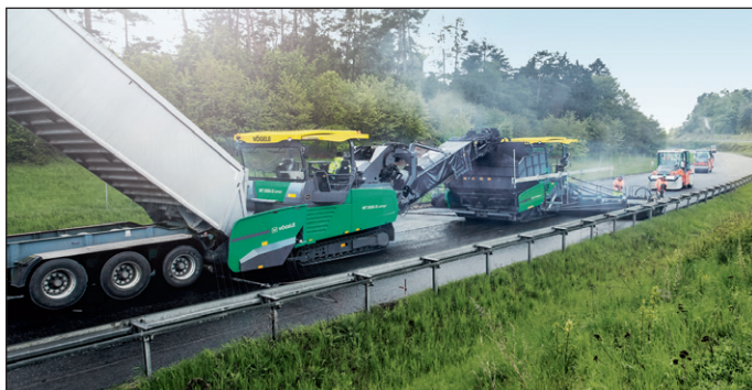
Figure 1.54 – Pose avec alimentateur inséré entre le finisseur et les camions l'alimentant
