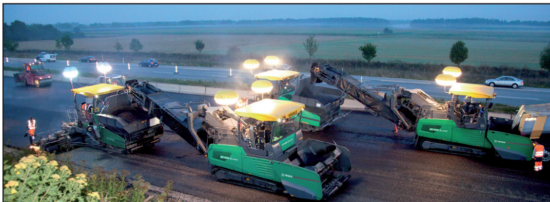
Figure 2.6 – Travaux de nuit
