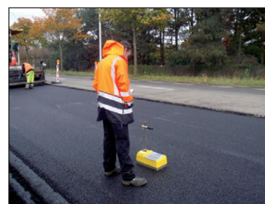
Figure 5.5 – Mesure de la densité au gammadensimètre
