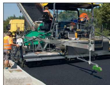
Figure 1.51 – Skis intégrateurs avec capteurs sans contact
