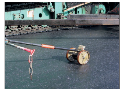
Figure 5.4 – Roue de mesure de la distance parcourue, accrochée au finisseur
