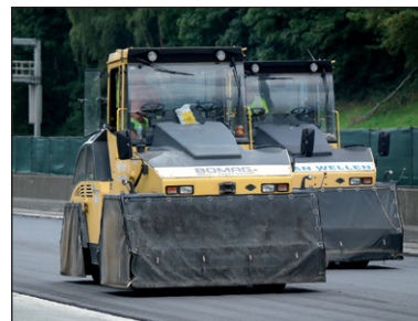
Figure 3.35 – Bâches de protection d'un compacteur à pneus
