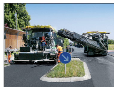
Figure 1.56 – Alimentation latérale par l'alimentateur
