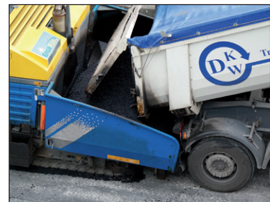
Figure 3.13 – Chargement du finisseur
