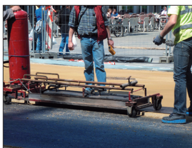
Figure 3.44 – Utilisation d'une rampe de réchauffage pour réchauffer les bords de l'enrobé coloré
