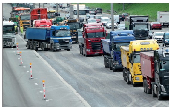
Figure 2.4 – Véhicules en excès sur chantier
