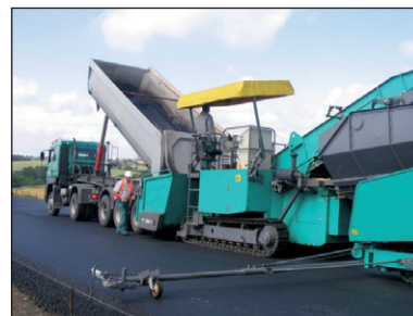
Figure 3.30 – Alignement longitudinal du finisseur
