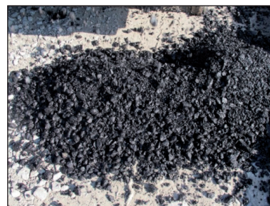
Figure 3.19 – Enrobé déversé à côté de la trémie
