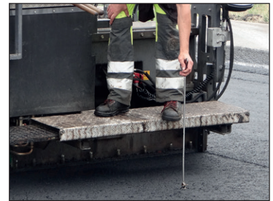
Figure 5.3 – Utilisation d'un fil pour contrôler le profil et le niveau
