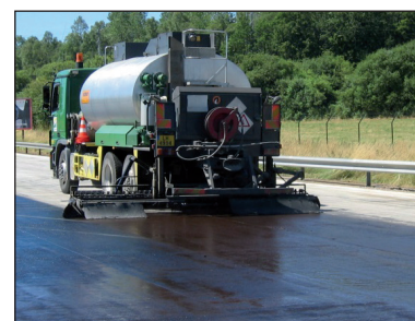
Figure 3.6 – Couche de collage en cours de pose
