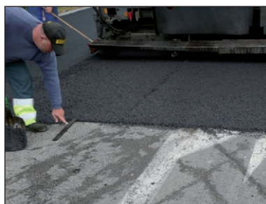
Figure 3.10 – Raccordement au revêtement existant
