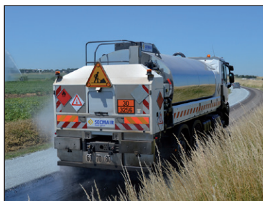
Figure 1.8 – Répandeuse de grande capacité
