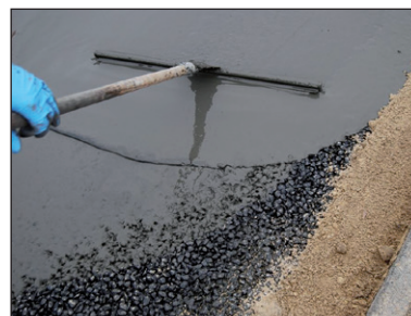
Figure 4.3 – Epannage du coulis
