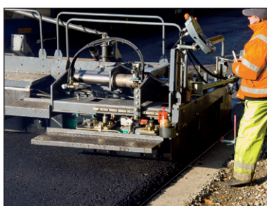
Figure 1.40 – Extensions boulonnées combinées avec des télescopiques
