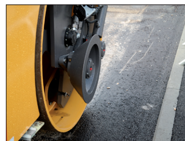
Figure 3.45 – Compactage à l'aide d'un cylindre latéral
