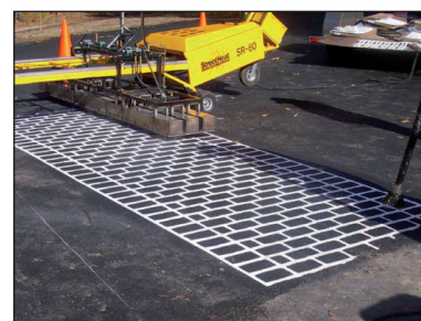
Figure 4.9 – Machine de réchauffement des enrobés
