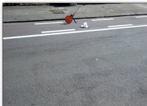
Figure 2 – Réalisation d'inspections visuelles sur les sections expérimentales par le CRR
