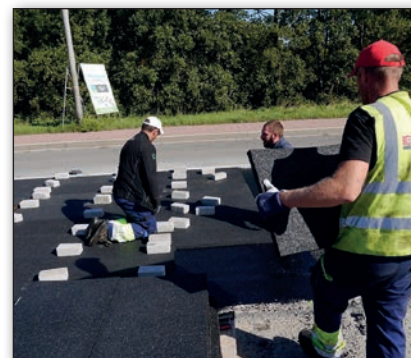
Des mesures effectuées sur la section expérimentale poroélastique ont démontré une réduction acoustique de 7 à 9 dB
